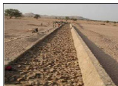
Le seuil d'épandage permet ainsi de rendre disponible des terres agricoles en saison pluviale et en contre saison, sans besoin d'arroser, de réhabiliter le niveau de la nappe phréatique et d'inverser les dégâts de l'érosion et de la dégradation des sols. Bien localisé dans le paysage, l'ouvrage doit permettre le retour à l'état d'équilibre avec, d'une part, l'arrêt de l'érosion, et d'autre part, la réimplantation de la végétation naturelle après rétablissement des régimes hydriques antérieurs.
